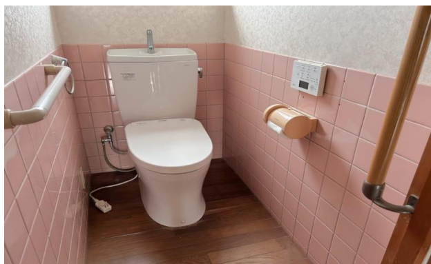
倉庫 1F トイレ ⑤
