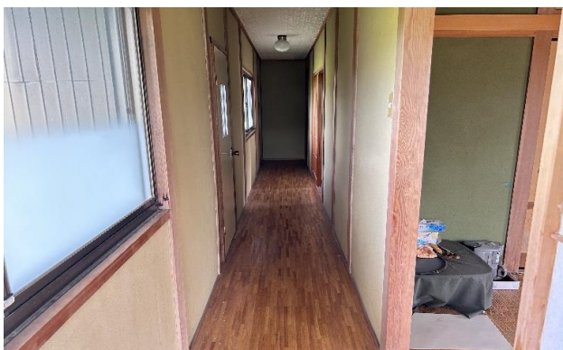
倉庫 2F 廊下 ⑬
