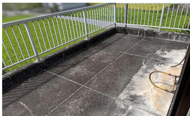
倉庫 2F バルコニー
