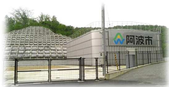
市場高区配水池
