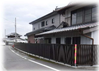
改修後のブロック塀
