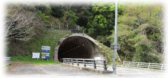
鵜の田尾トンネル（1,769m）
