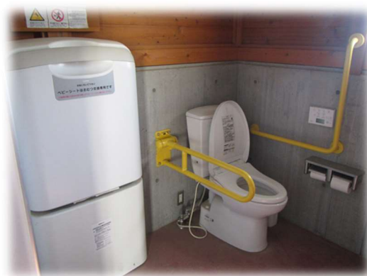
改修された多目的トイレ
