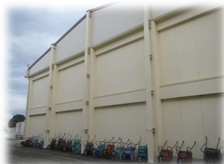
外壁を耐震補強した体育館
