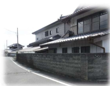
改修前のブロック塀
