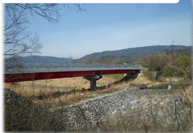
●高尾橋（土成町） 昭和41年建設
