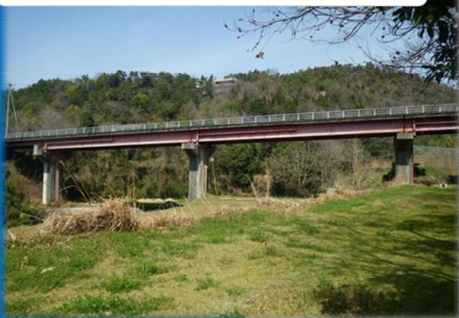
●芝生谷大橋（阿波町） 昭和57年建設
