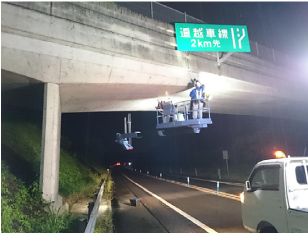
橋梁点検車による近接目視 高速道路の修繕工事(夜間通行止め)に 合わせて実施
