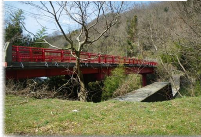
●金清橋（市場町） 昭和52年建設
