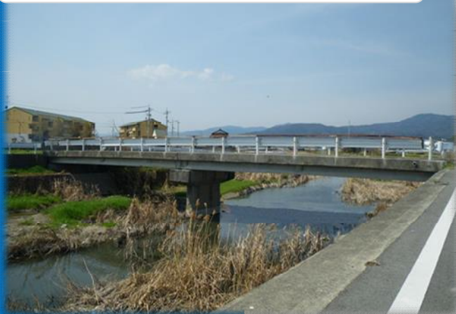
●第2案内橋（吉野町） 昭和54年建設
