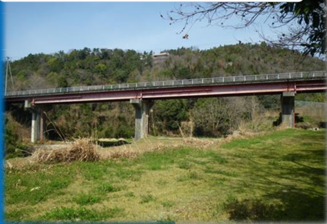
●芝生谷大橋（阿波町） 昭和57年建設
