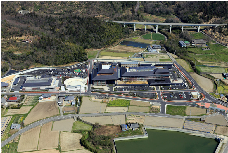
市役所本庁舎に設置された太陽光発電設備（航空写真）
