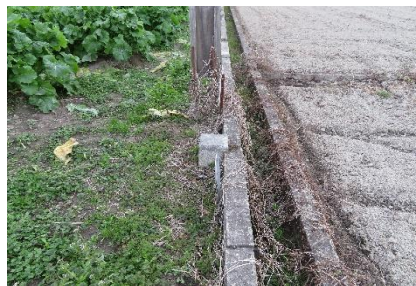
用水路壁との状況(東から)
