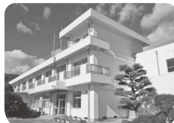
▲土成小学校校舎大規模改修事業
