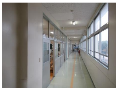
写真 11：内部仕上調査
