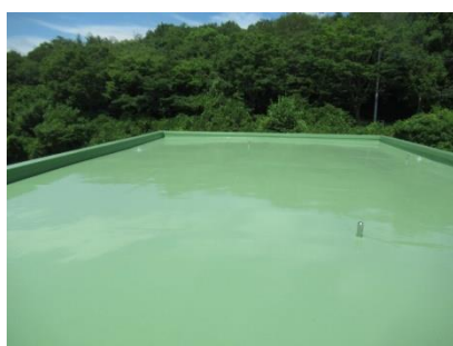
写真 9：屋根・屋上調査
