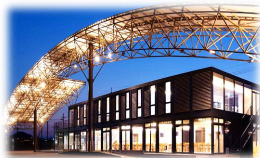
松茂町交流拠点施設「Matsushigate」 複合施設
