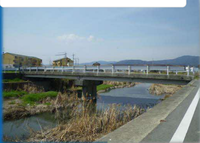
●第2案内橋（吉野町） 昭和54年建設
