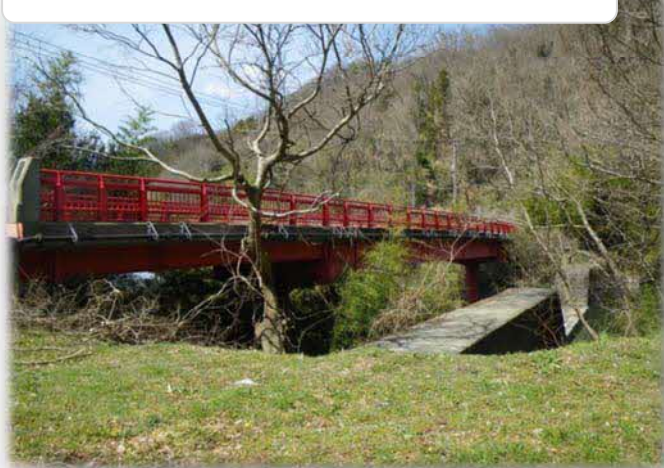
●金清橋（市場町） 昭和52年建設
