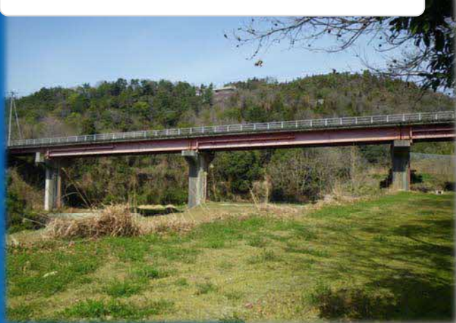
●芝生谷大橋（阿波町） 昭和57年建設
