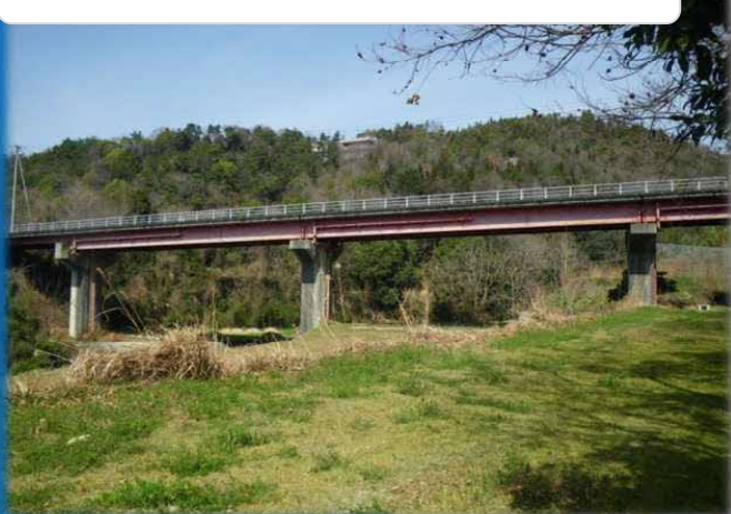
●芝生谷大橋（阿波町） 昭和57年建設
