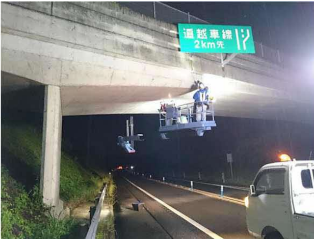
橋梁点検車による近接目視 高速道路の修繕工事(夜間通行止め)に 合わせて実施
