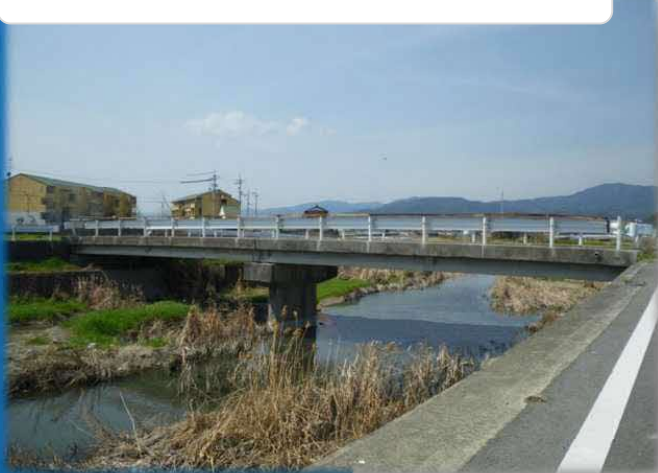
●第2案内橋（吉野町） 昭和54年建設
