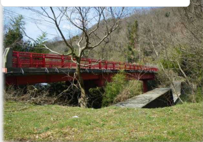
●金清橋（市場町） 昭和52年建設
