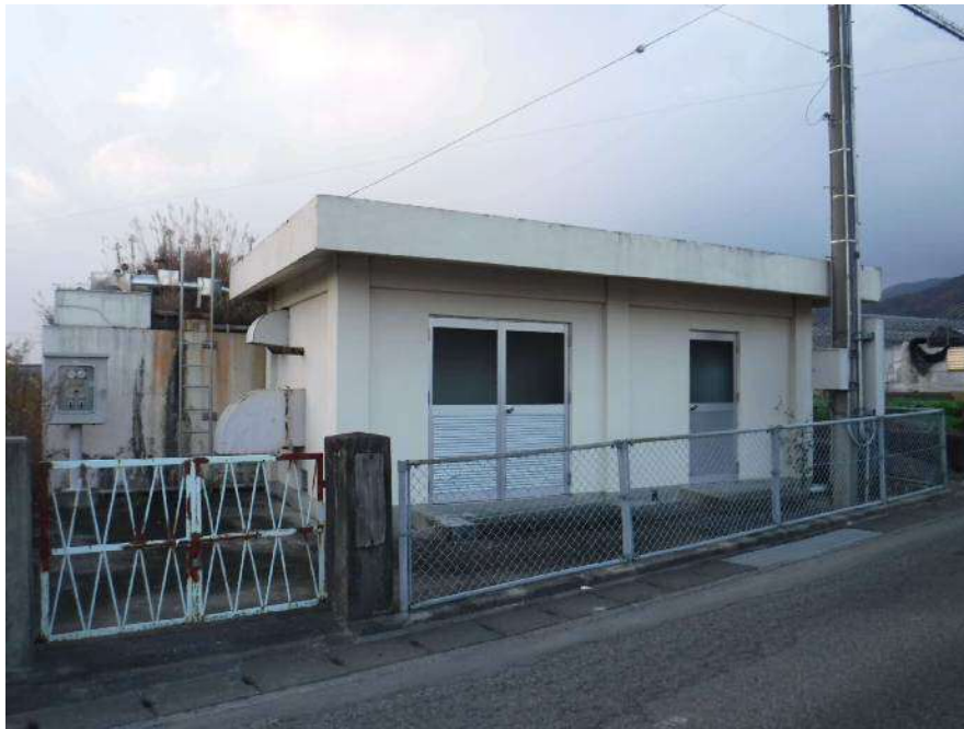
早田ポンプ場
