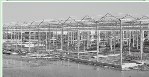
現在の工事状況
