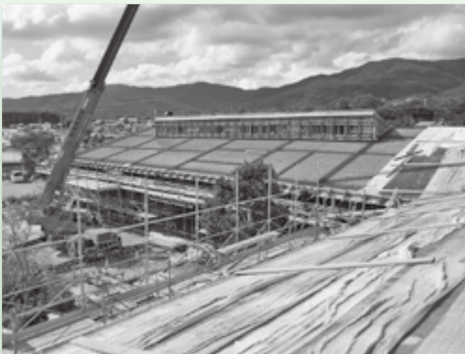
公民館側(建物西側)
