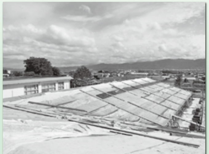
図書館側(建物東側)屋根部分
