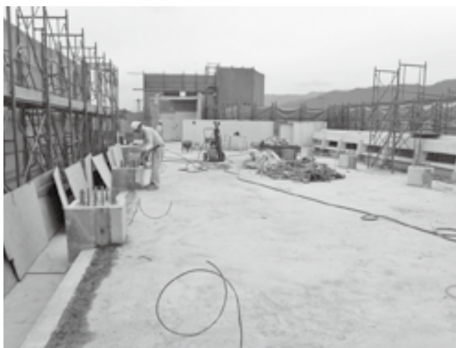
減築後の旧3階フロア状況
