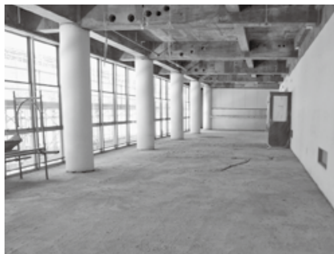
2階南側の内装撤去状況
