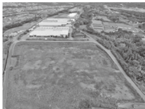
段ボール工場建設地
