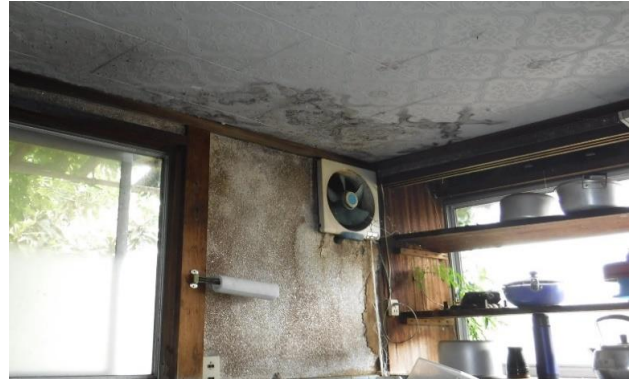
台所⑪ 天井・壁
