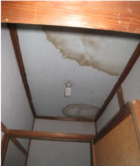
トイレ 大天井
