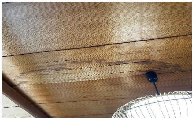
1F ② 廊下 天井
