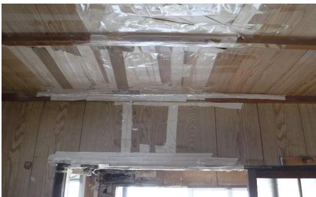
和室 ⑦ 天井
