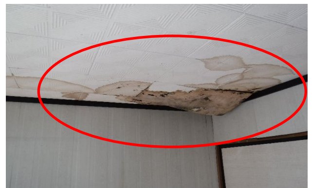
洋室 ⑧ 天井
