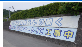
【(仮称)阿波スマートインターチェンジ工事】
