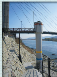
水位塔(写真手前)
