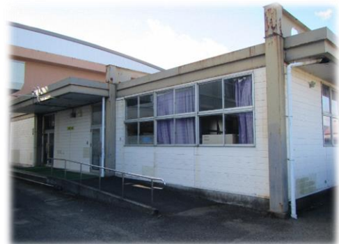
〔市場中学校技術室棟〕
