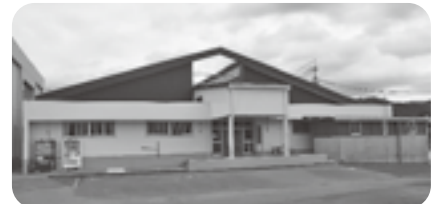
市場武道館改修事業 完成写真
