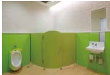
こどもトイレ 小さなこどもでも使いやすいように、形や大きさを工夫したこども専用のトイレを設置しています。
