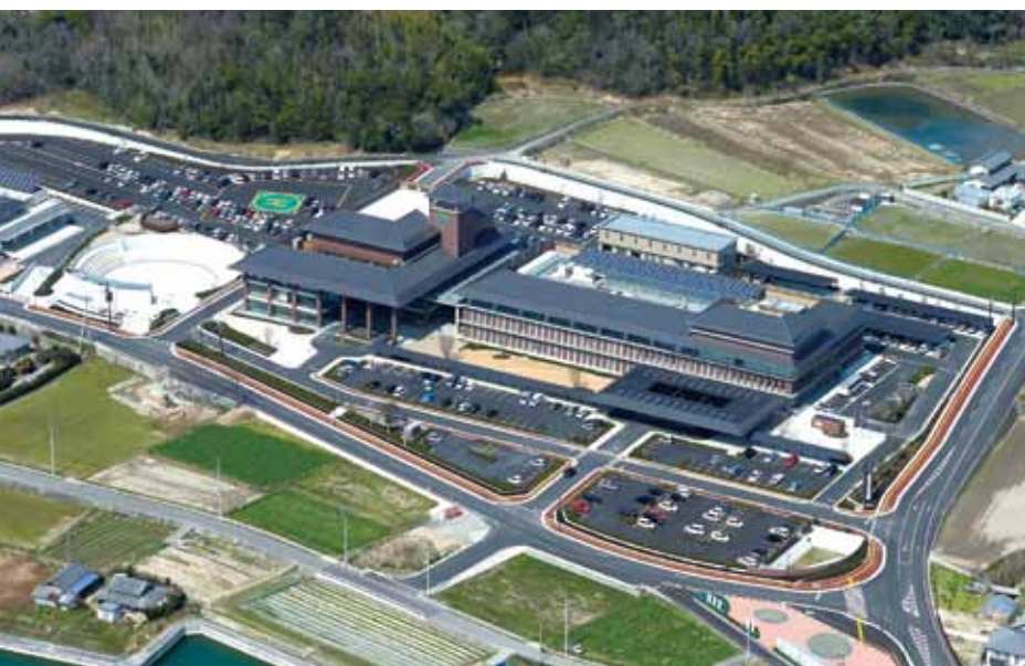
上／阿波市役所外観、下／阿波市役所全景
