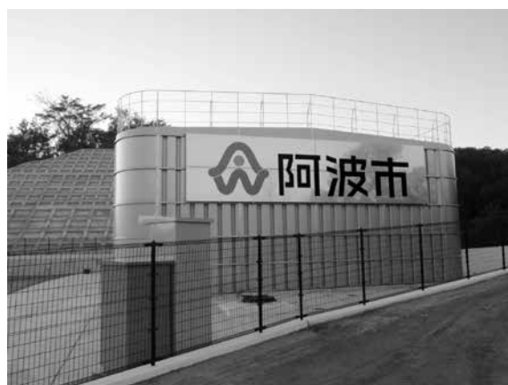
▲ 市場高区配水地
