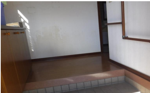
1F 廊下 ②
