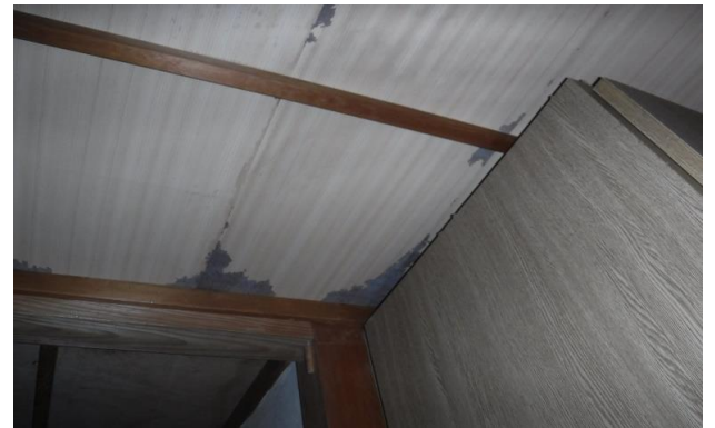
1F 和室 ㉞ 天井
