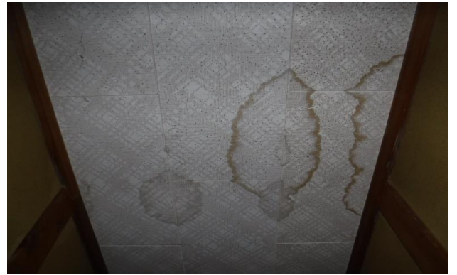
1F 廊下 ㉗ 天井
