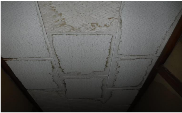
1F 廊下 ㉗ 天井
