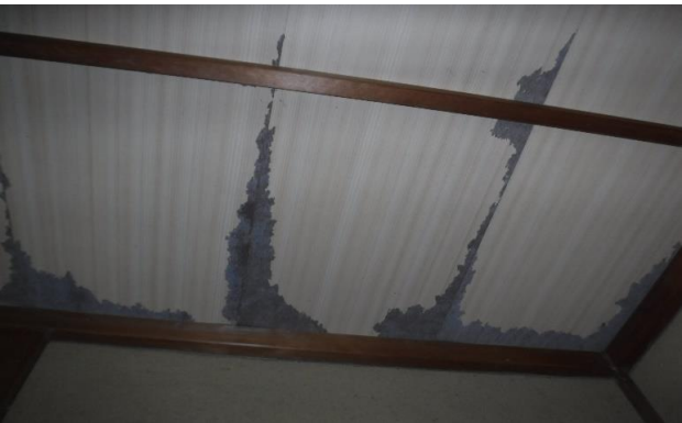
1F 和室 ㉞ 天井
