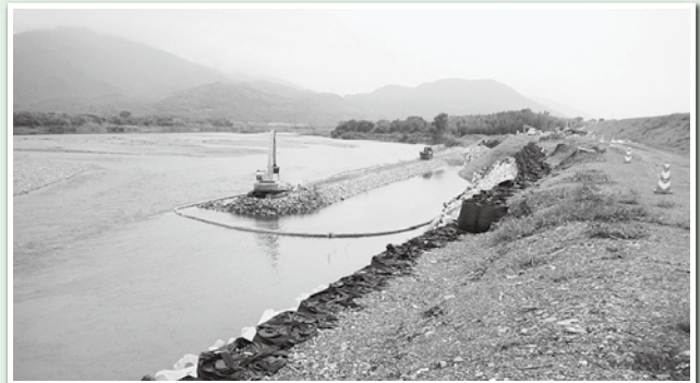
捨て石工の施工状況
