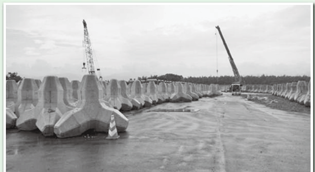
根固めブロックの製作状況
