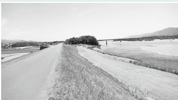
施工箇所全景
