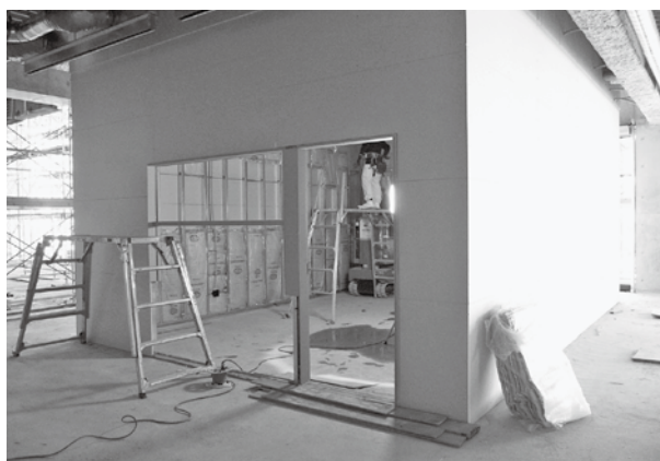
交流防災拠点施設棟 事務室内装ボード工事
