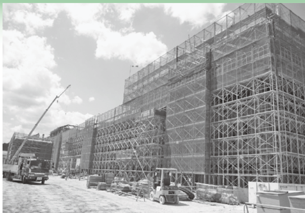
庁舎棟・交流防災拠点施設棟 工事全景
