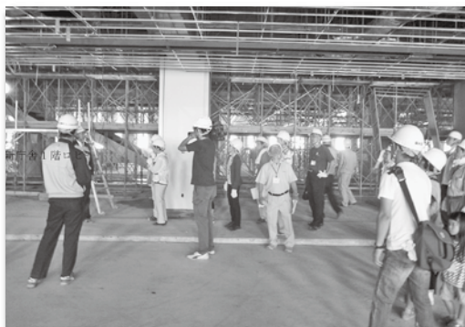
新庁舎1階ロビー
