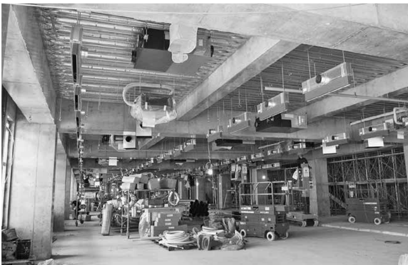
設備・内装工事風景
