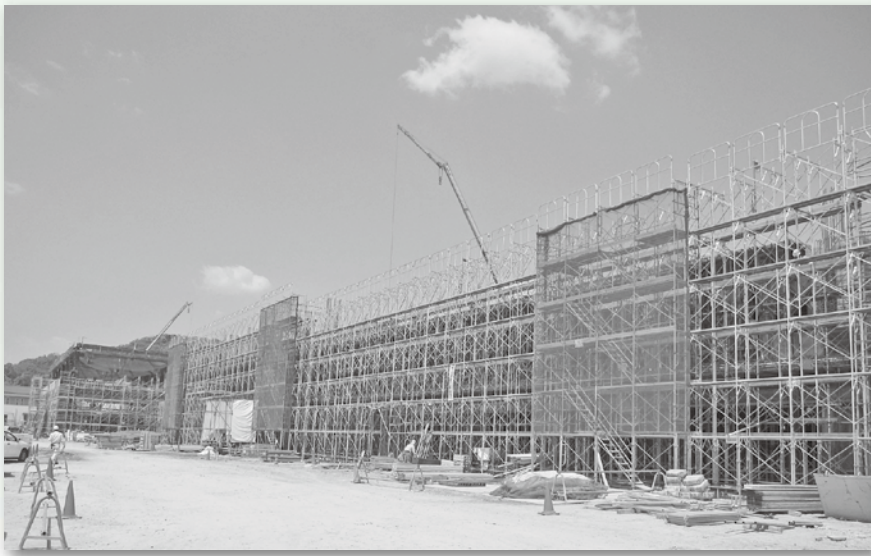
庁舎棟・交流防災拠点施設棟 躯体工事全景
