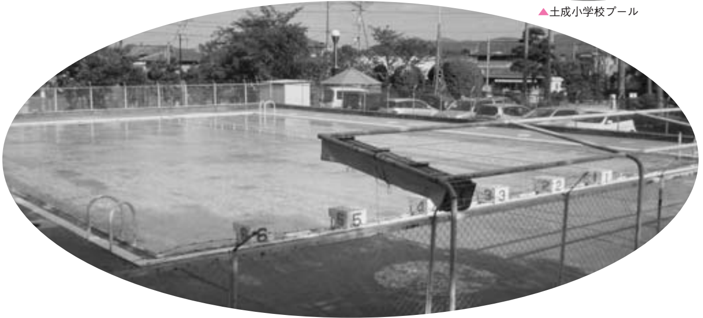
▲体育教育環境整備「土成小学校プール改築事業」
