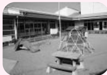
▲保育所遊具整備
