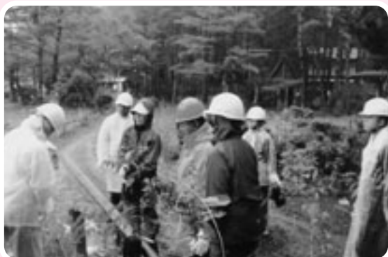
広葉樹の植栽作業風景
