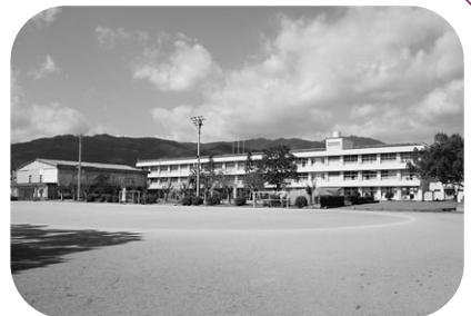
▲伊沢小学校大規模改修事業
