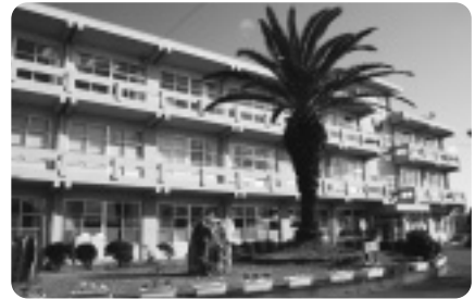
土成中学校耐震補強工事
