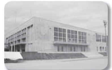
土成中学校屋内運動場改築事業
