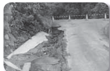
公共土木施設災害復旧事業
